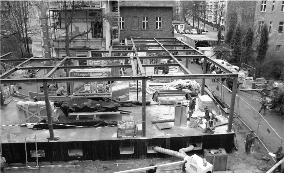
Neubau und Renovierung der Suppenküche 2003-2004. (Quelle: Festschrift 25 Jahre Suppenküche)
