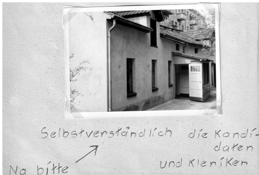
Wirtschaftsgebäude hinter dem Kloster nach den Renovierungsarbeiten zu Beginn der 60er Jahre (Quelle: Chronik der Ordensbrüder)
